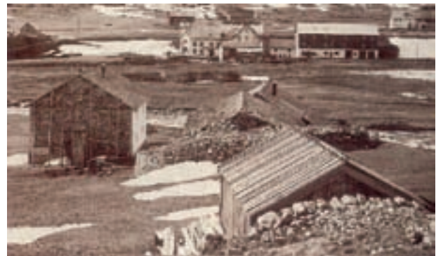
Bereits 1613 wurden zum Schutz des Weiler Pirche Schutzmauern errichtet.
