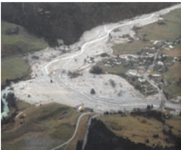
Die Raumnutzung in bestimmten Gebieten wird immer stärker natürlichen Prozessen ausgesetzt. Die Abbildung zeigt den Ort Log pod Mangartom in Slowenien, der 2000 von einer Mure verschüttet wurde.
