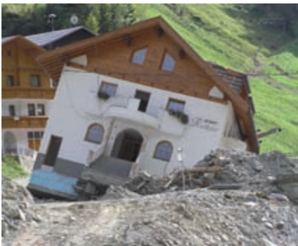
Hochwasserschäden im Paznaun, September 2005: Naturgefahren bedrohen die Existenz.
