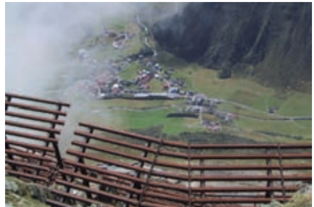
Lawinerverbauung: 51 Lawinenstriche, 221 ha Abbruchfläche
