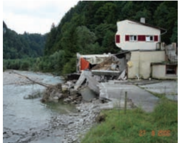
Hochwasserschäden an der Sense (22.8.2005). In diesem Fall braucht das Gewässer mehr Raum und die Bauten müssen verlegt werden.
